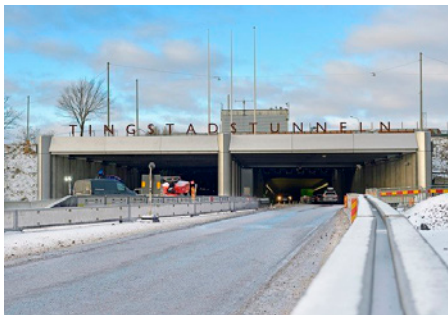
Tunnel, Tingstadstunneln Bild: Limeco
